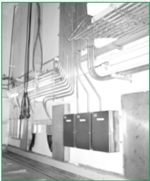
Reaktoriaus valdymo strypų prijungimo instaliacija ir sujungimų spintelės.
